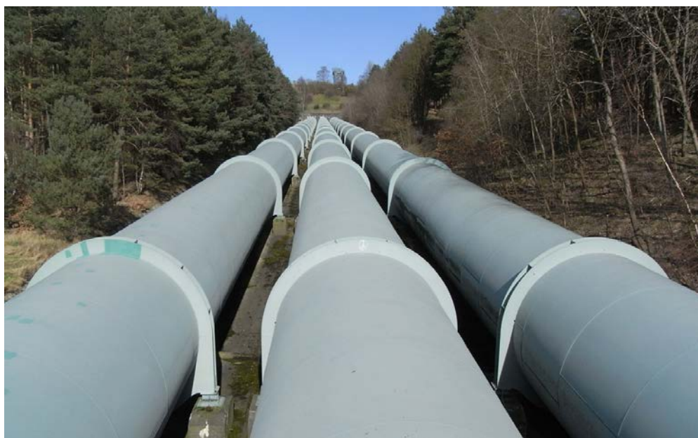
Рисунок 1 – Общий вид трубопровода
