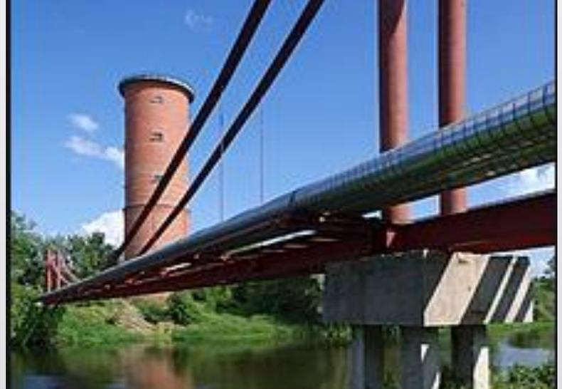
Арочный, подвесной трубопровод - разновидность надземных переходов, выполняемых в виде арки; сооружаются через различные препятствия (рисунок 1.2).
