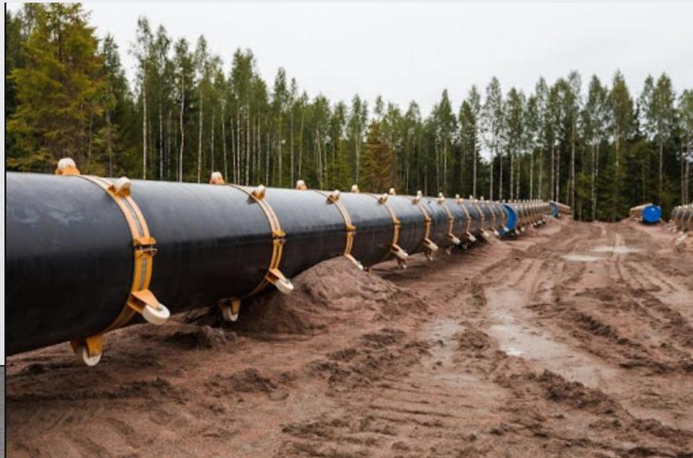
Надземный трубопровод – комплекс сооружений для транспортирования газообразных, жидких или твёрдых продуктов, прокладываемый на отдельных опорах или эстакадах на расстоянии от грунта не менее 25 см.
