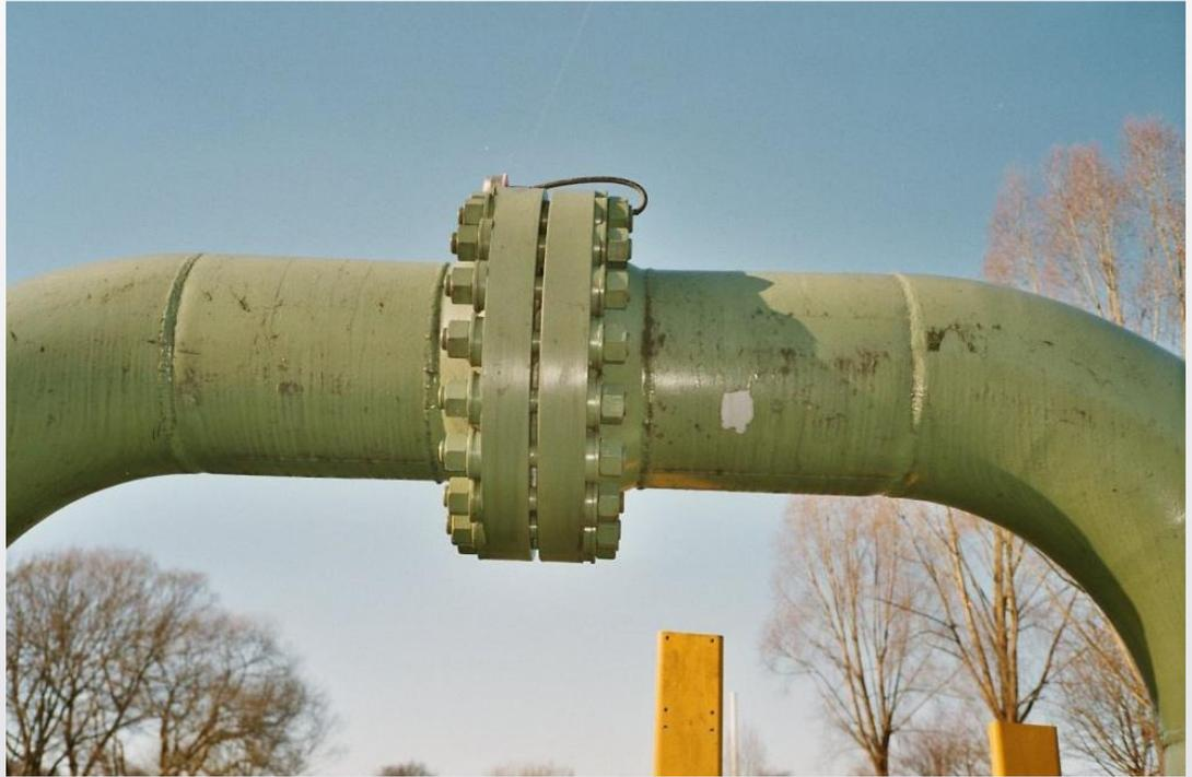
Отво́д (син. колено; угольник) — изделие, фитинг, предназначенный для изменения направления потока жидкости (газа) в трубопроводе (рисунок 1.9)
