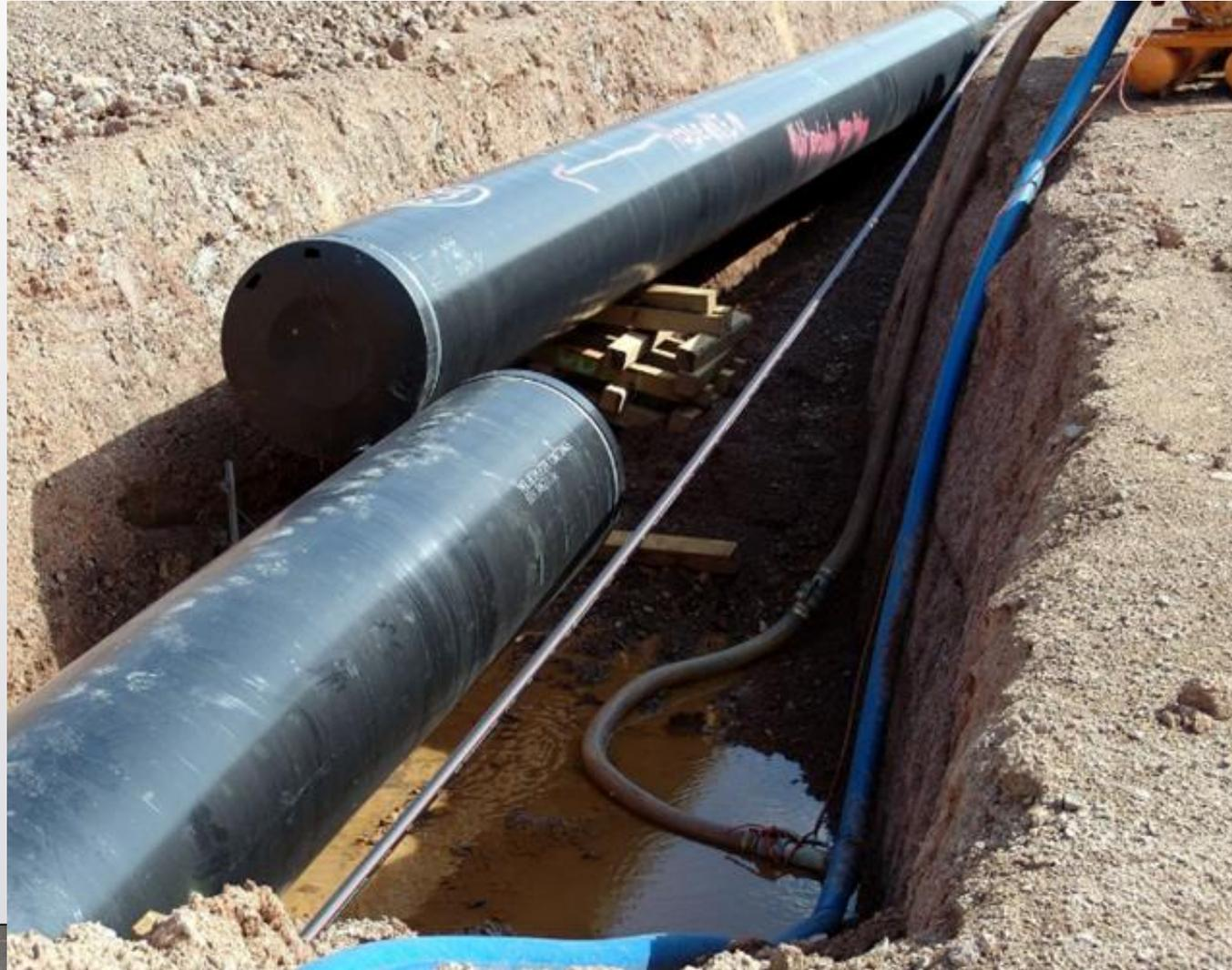
Подземные трубопроводы для перекачки нефти и газа характеризуются значительной протяжённостью, достигающей многих тысяч км, большими диаметрами (до 1420 мм) и рабочим давлением 7,5 и более МПа. Подводный трубопровод – укладывается по дну водоёмов, рек или в траншеях, прорытых на дне.
