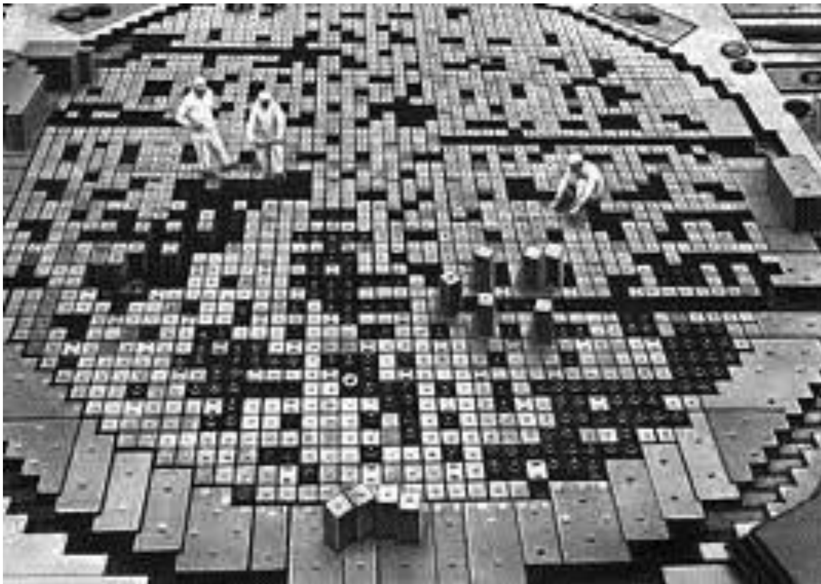
Сборка активной зоны ядерного реактора
