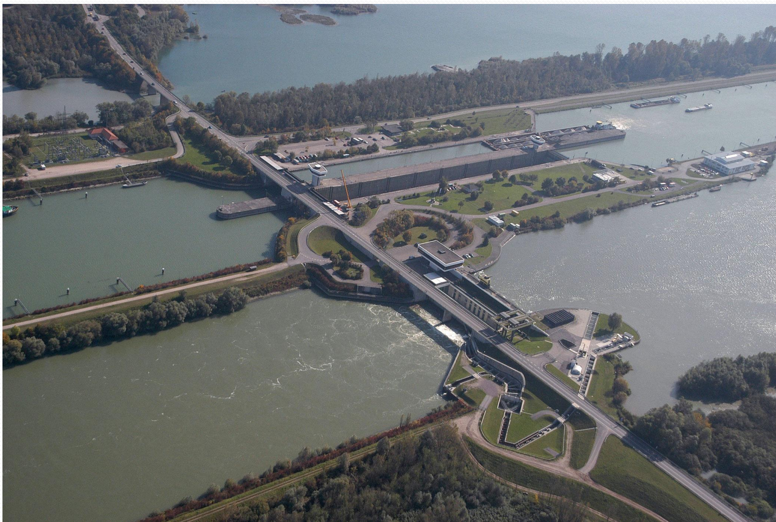
Пример низконапорной русловой гидроэлектростанции – ГЭС Иффецхайм на Рейне, введена в эксплуатацию в 1978 году.
