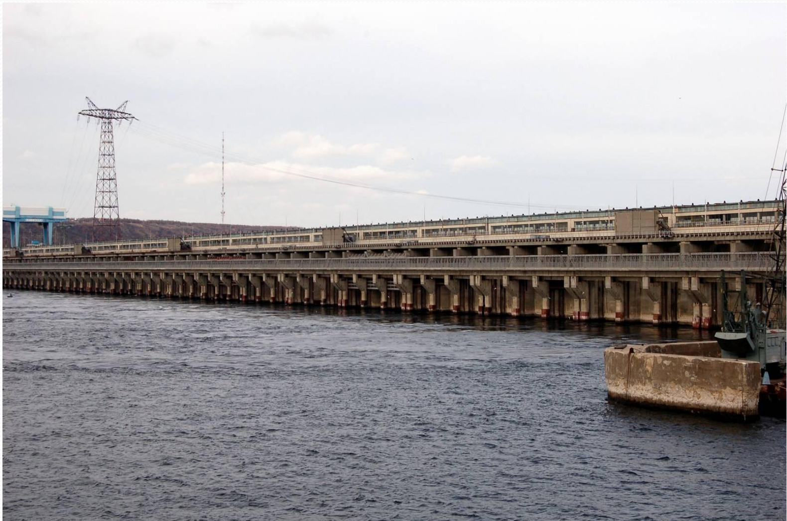
Саратовская ГЭС руслового типа расположена на границе Среднего и Нижнего Поволжья, в 1129 км выше устья р. Волга, у города Балаково, на левобережной пойме.
