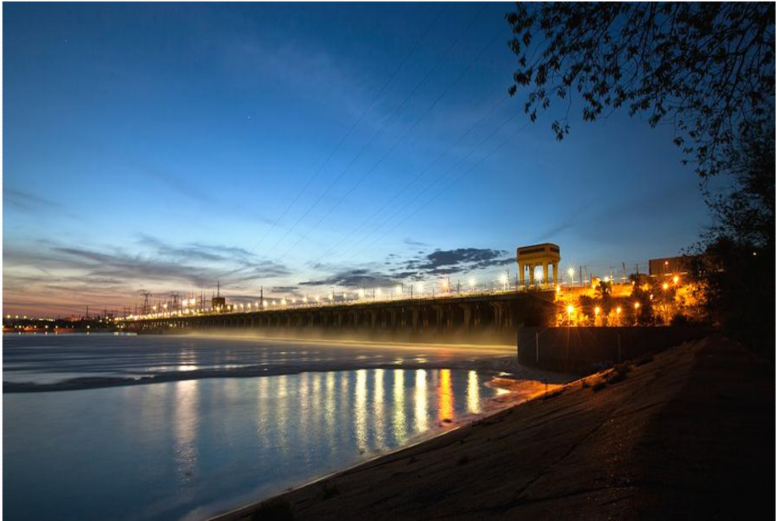
Волжская ГЭС — средненапорная гидроэлектростанция на реке Волге в Волгоградской области, в городе Волжском. Крупнейшая гидроэлектростанция в Европе.
