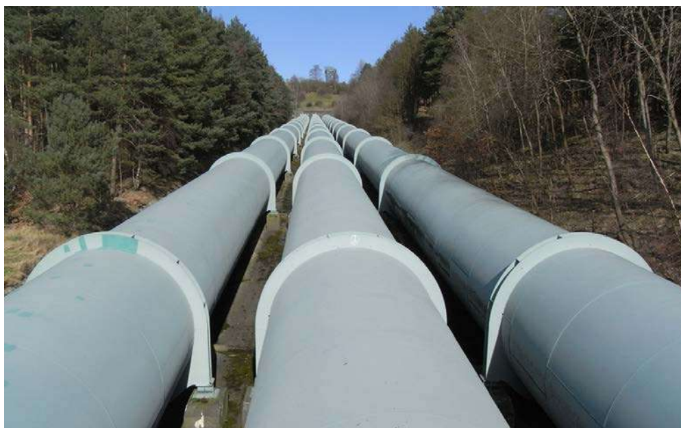
Рисунок 1 – Общий вид трубопровода
