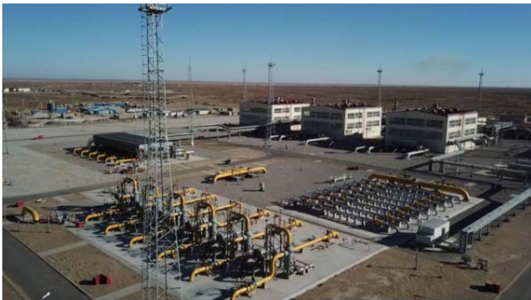
Рисунок 1.8 – Компрессорная станция СКС-1 газопровода Казахстан-Китай
