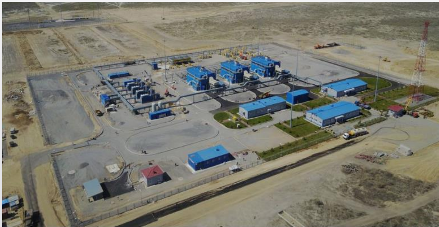
Рисунок 1.4 – Компрессорная станция газопровода Бейнеу-Бозой-Шымкент
