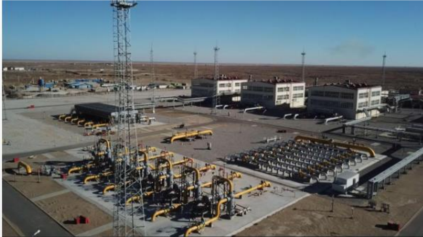
Рисунок 1.8 – Компрессорная станция СКС-1 газопровода Казахстан-Китай
