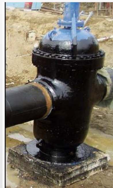
а- задвижка; б - плита Рисунок 1.3 – Арматура нефтепровода
