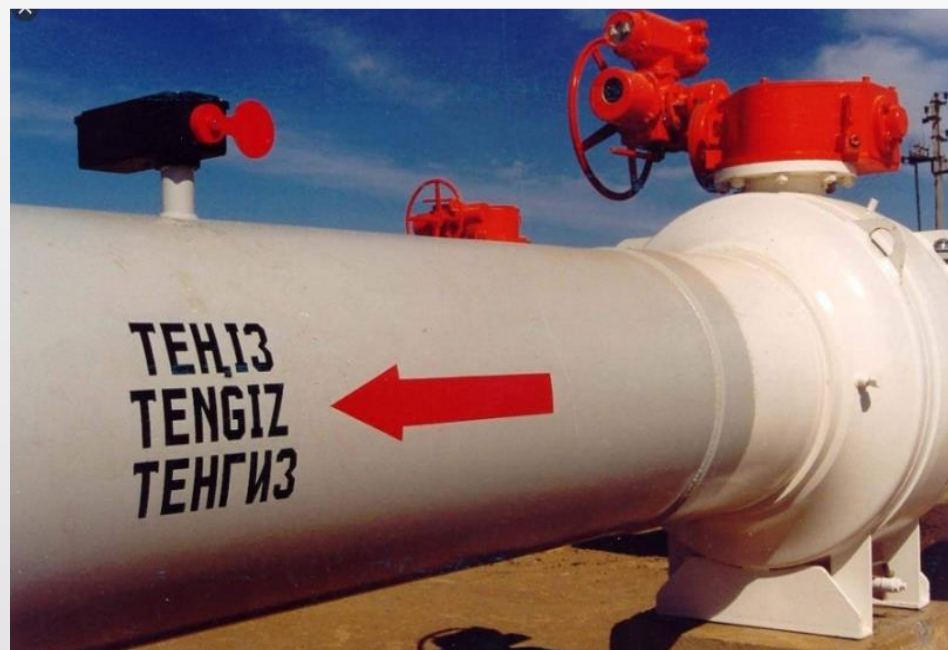
а- задвижка; б - плита Рисунок 1.3 – Арматура нефтепровода
