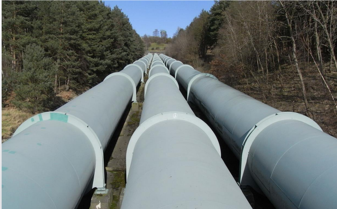
Рисунок 1 – Общий вид трубопровода
